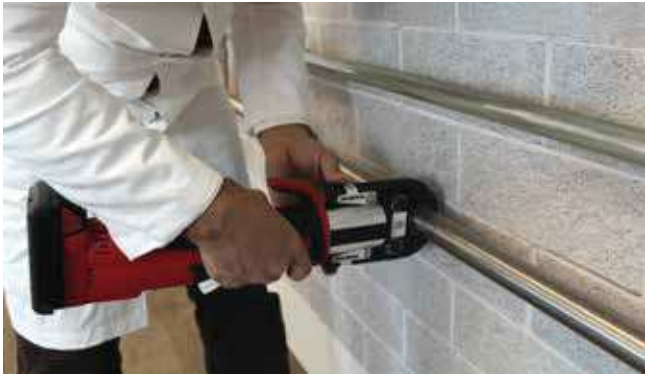
Zhotovení lisovaného spoje
