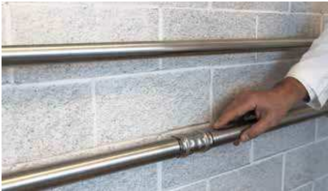
Kontrola lisovaného spoje
