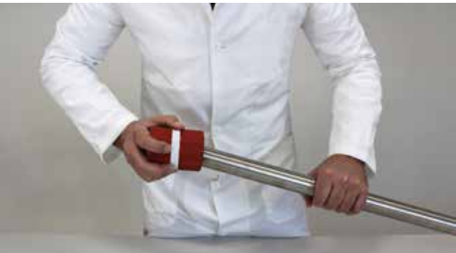
Entgraten des Leitungsrohres
