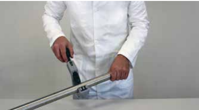
Ablängen des Leitungsrohres
