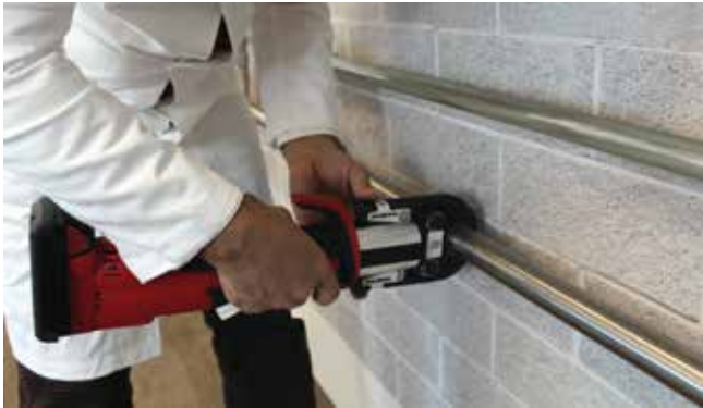
Herstellen der Pressverbindung
