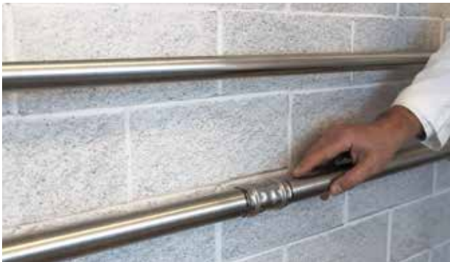
Kontrolle der Pressverbindung
