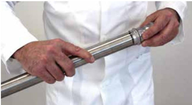
Einführen des Rohres in den Pressfitting
